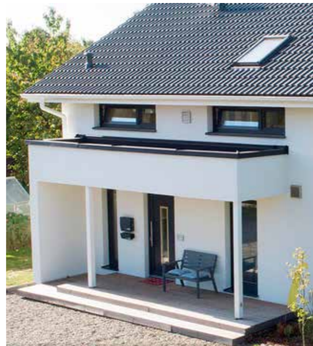
Moderne Flachdachversion einer Eingangsüberdachung
