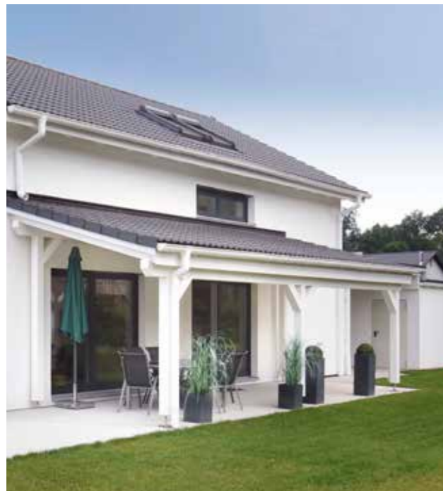
Solides Dach über der Terrasse
