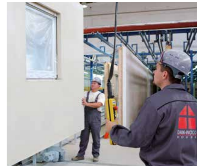
Die Wände werden in der Fabrik vorgefertigt...
