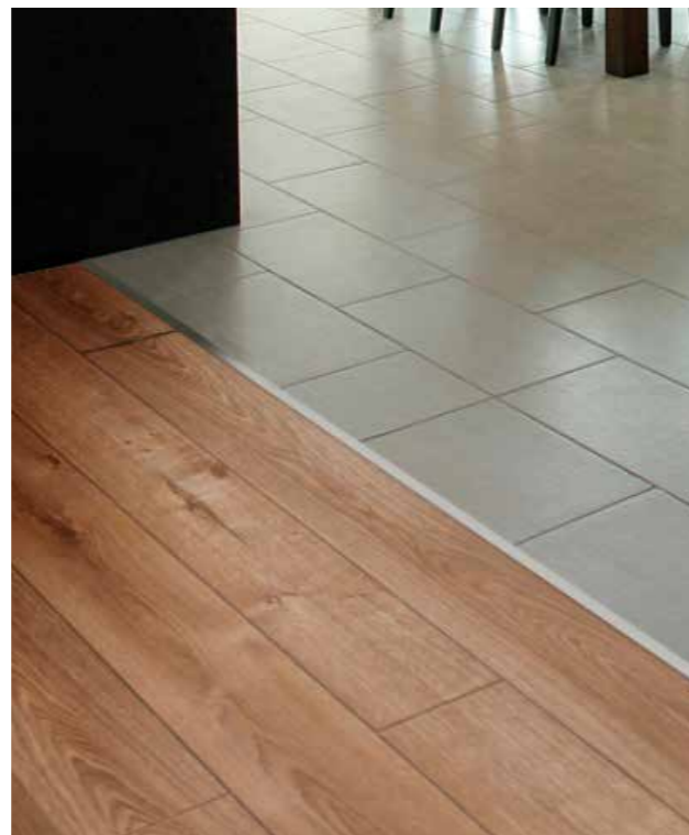
Übergänge zwischen zwei verschiedenen Bodenbelägen werden mit einer Fußbodenleiste kaschiert.
