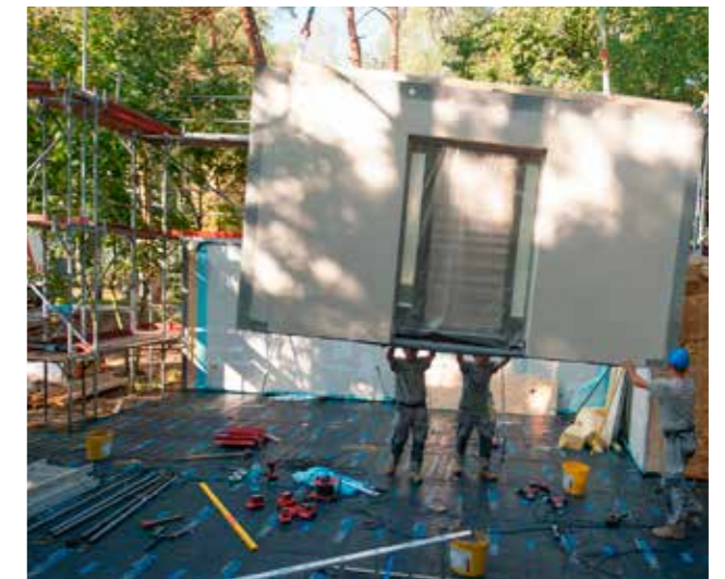
... auf LKW zum Bauplatz transportiert...
