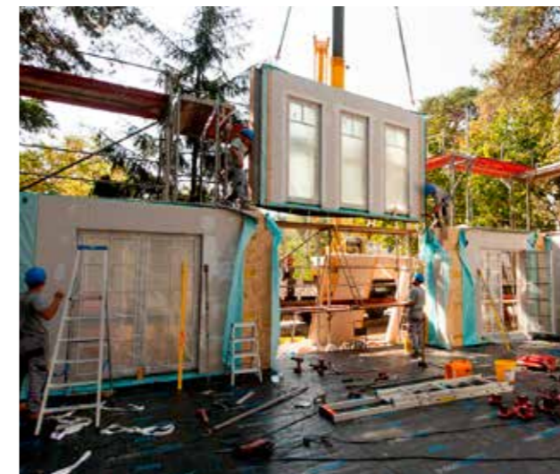
...und das Erdgeschoss auf das Fundament montiert. Anschließend wird das Obergeschoss aufgesetzt.
